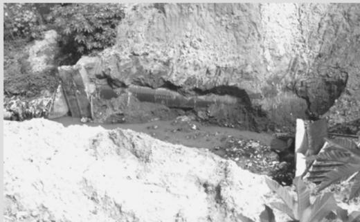
... região está abandonada e sem a conclusão; com a proximidade das chuvas de final de ano, há risco de assoreamento, e queda de barrancos no setor inacabado.
