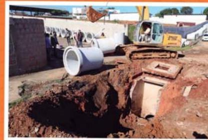
> Construção da galeria para captação de águas pluviais no bairro Rubens Rocha Gonçalves
