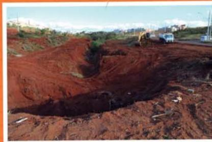
> Recuperação de área de erosão no Jardim Mediterrâneo com captação de águas pluviais
