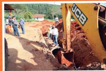
> Implantação da rede para captação de águas pluviais na comunidade de Termópolis
