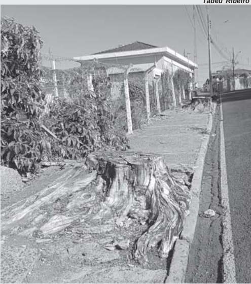
Dois enormes tocos de árvores sobre a calçada na Rua Alfredo Fidelis Marques, Bairro Lagoinha, que perigosamente obriga os pedestres caminharem dentro do leito desta via pública
