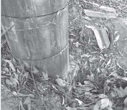
No Cidade Industrial, vazamentos de água fedorenta em caixas de esgoto da COPASA, foram concertados
