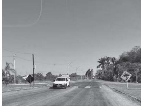
Redutor de velocidade na MG-449, em Arceburgo, com sinalização precária e massa asfáltica deteriorada, causando transtornos a motoristas
