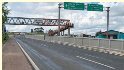
Simulação da contenção de concreto feita pelo vereador Biju garantindo a segurança dos bairros João 23 e São Pedro
