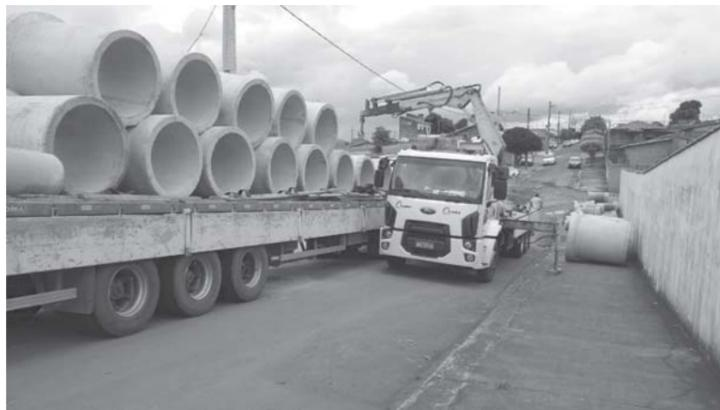
Caminhão Guincho retirando tubulões que irão canalizar águas pluviais em ruas dos Bairros Rubens Rocha, Acapulco e Mediterrâneo
